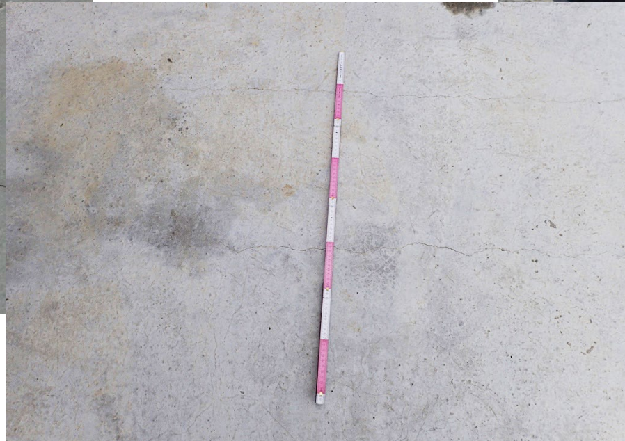
Retrait de séchage Fissures espacées régulièrement
