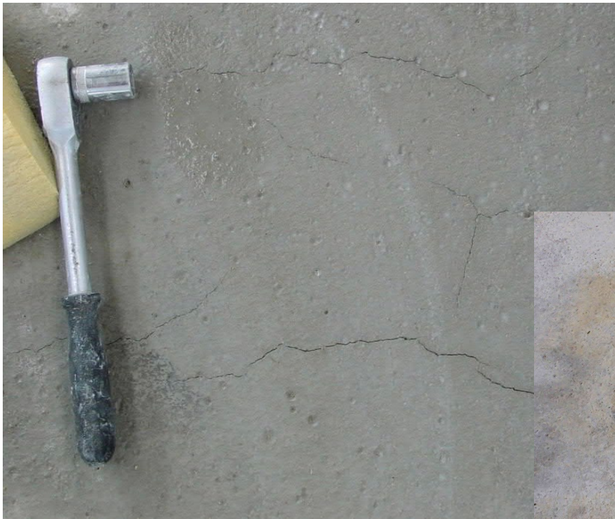
Retrait plastique Réseau de fissures irrégulier, fissures discontinues
